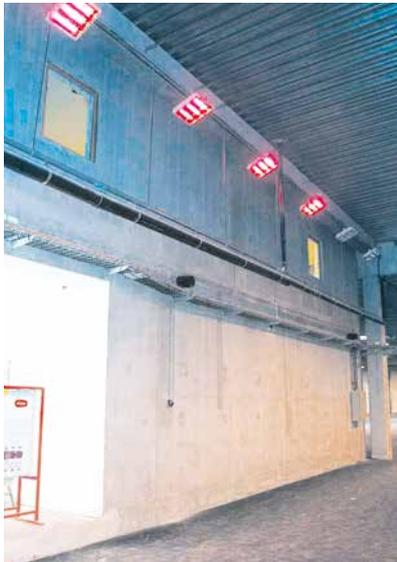
El IRCF se puede montar en la pared o en el techo y es adecuado para recintos que se usan esporádicamente, como esta área de salida de una pista de karts.
